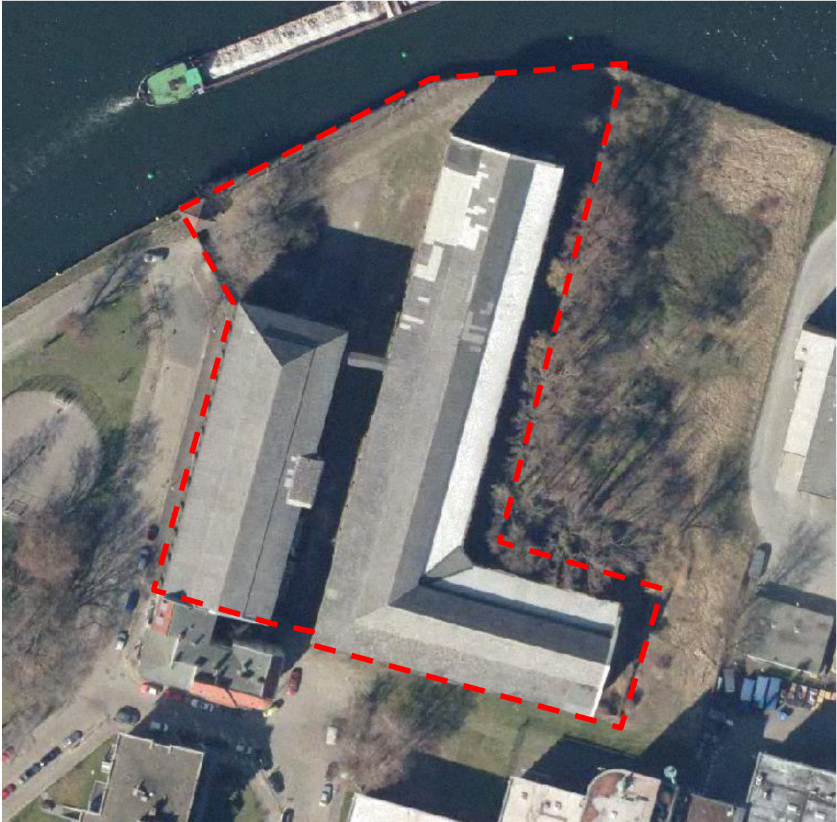
Abb. 1: UG mit Hallen der ehemaligen Geschützgießerei
