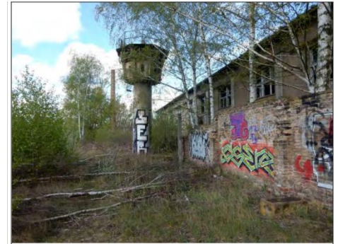
Foto 2: Verfallene Gebäude mit Gehölzaufwuchs und Totholz im Süden
